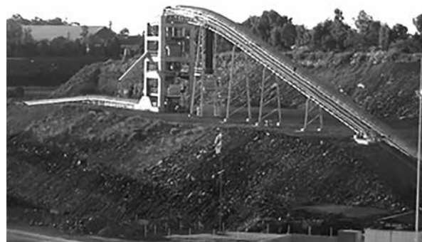
Figura 3: Vista general de la estructura del edificio
