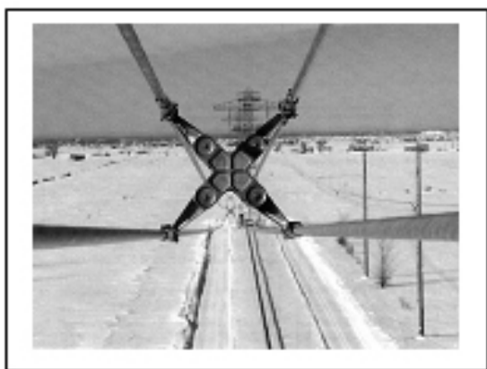
Figura 1 Espaciador amortiguador
