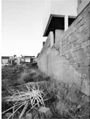
Fig.2. Terreno baldío lindero
