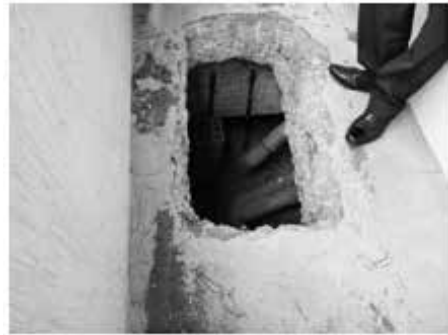
Fig.5. Rotura del contrapiso realizada para verificar la condición de las instalaciones sanitarias (en esta fotografía la instalación ya había sido reparada).
