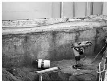
Fig.9. Equipo manual de compactación utilizado para compactar el relleno
