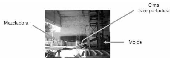
Figura 3. Disposición de equipos en el proceso de fabricación de los tubos.
