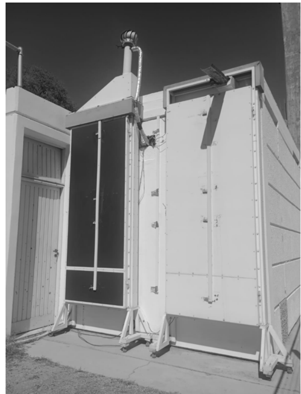
Figura 3: Eco paneles adosados a muro Este LEVS.
