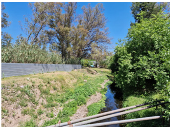
Figura 4 Puente Fernández. Tramo entre las calles La Plata y Entre Ríos de calidad regular según el índice.
