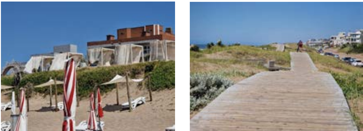
Figura 3: Avance excesivo de servicios de sombra y pasarela sobre dunas en Pinamar.
