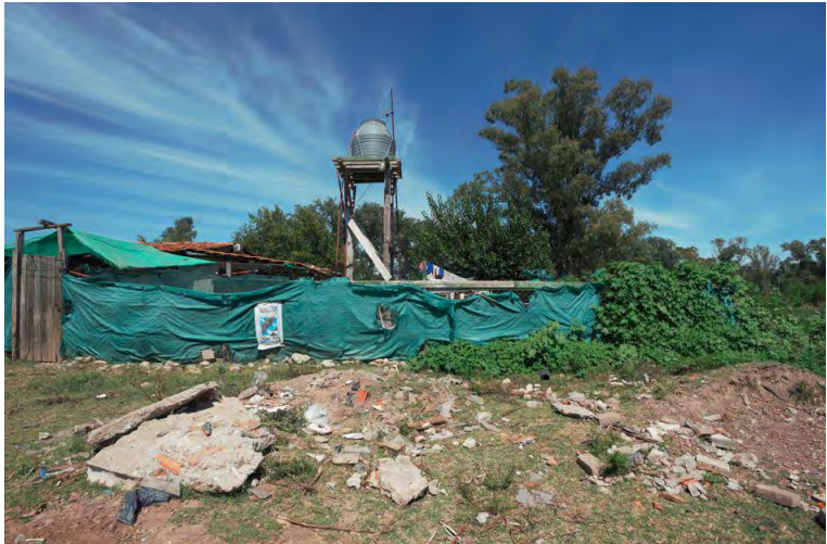
Figura 5: Tanque de reserva domiciliario. Fotografía: Miguel Caamaño.
